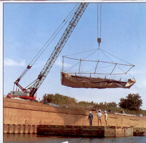
Chargement de l'enveloppe sur le ponton de transport
