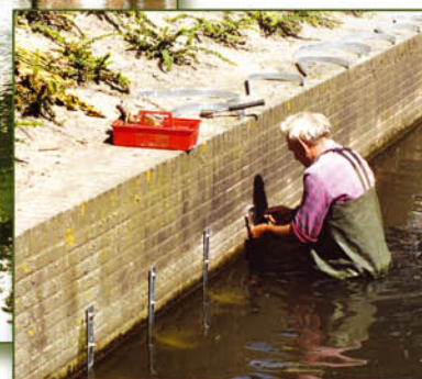
Fixation des berceaux sur le quai
