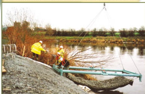
Palonnier sans détérioration du couvercle
