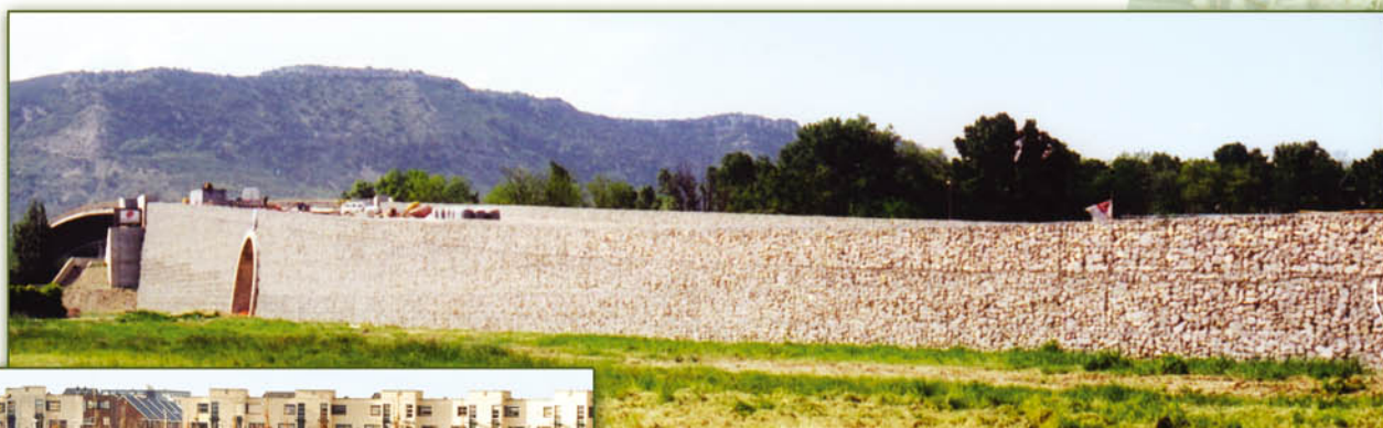
Rampe d'accès au pont de Valence (26) hauteur 3 à 12 m
