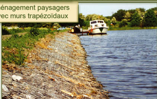
Protection de berge par matelas
