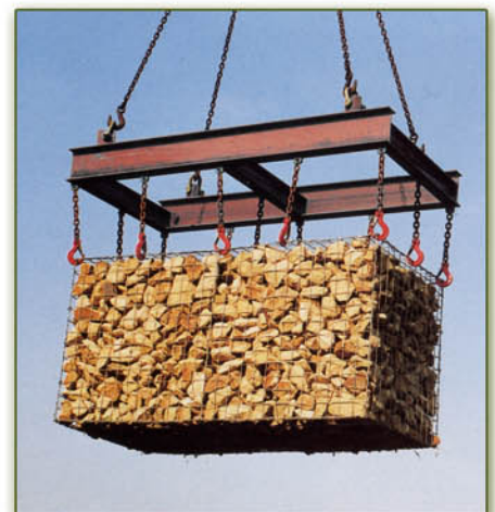
Préfabrication et manutention sans déformation
