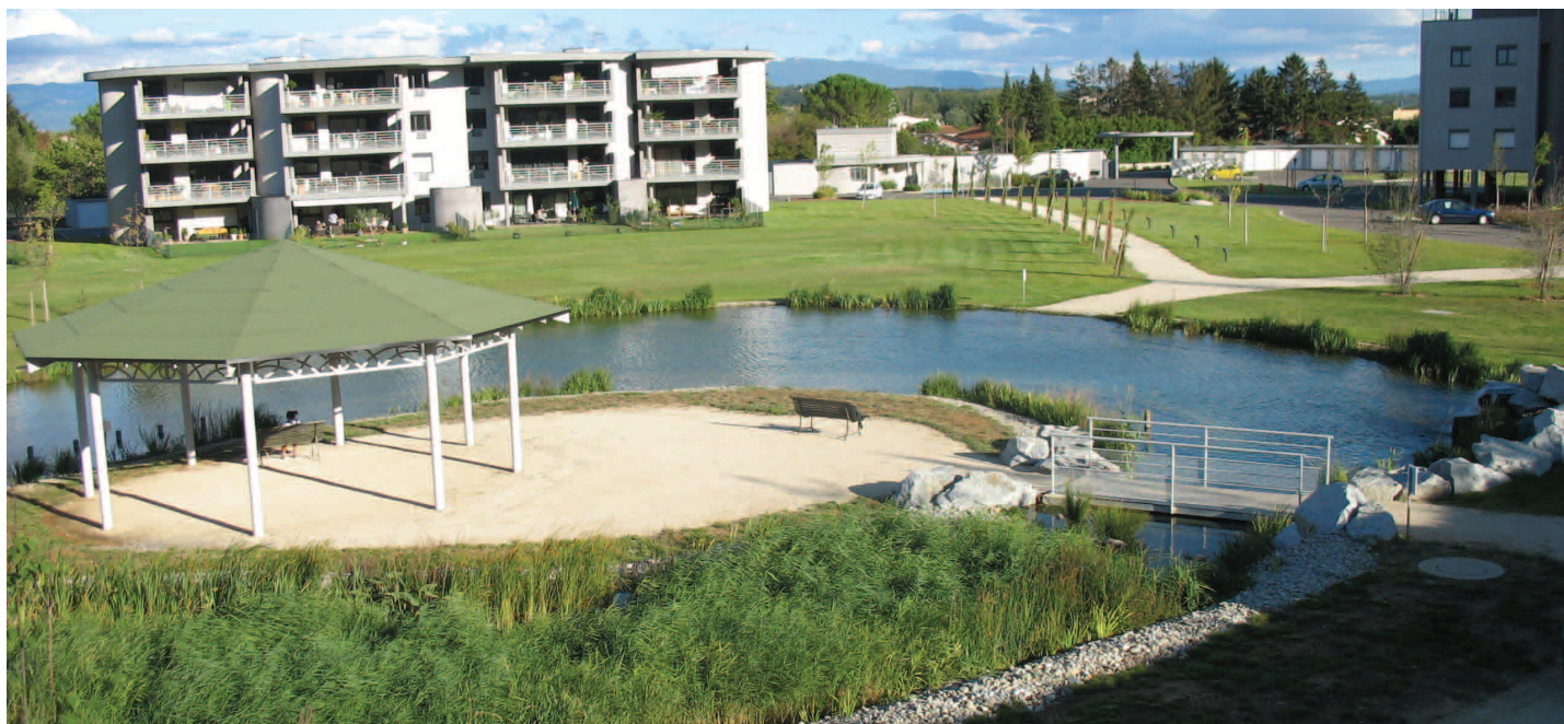
Berges du bassin, végétalisées par des géonattes coco d'hélophytes, Septembre 2010
