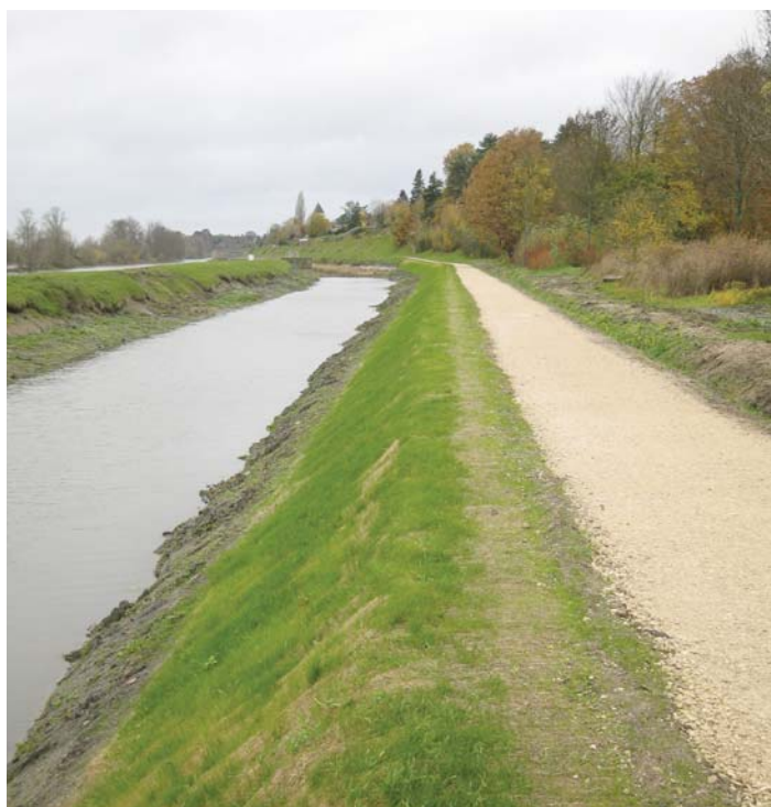
Le même chantier en décembre
