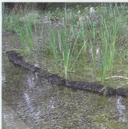
**Utilisées en génie végétal et pour l'épuration de l'eau**, ces fascines en fibres naturelles de bois transformées par diagenèse (Xylit) protègent de l'érosion les berges des rivières, de lacs ou d'étangs. Mises en œuvre bout à bout, superposées ou empilées en pyramide, elles résistent à la dégradation biologique et fonctionnent comme un filtre. Leur durabilité dépasse trente ans.
